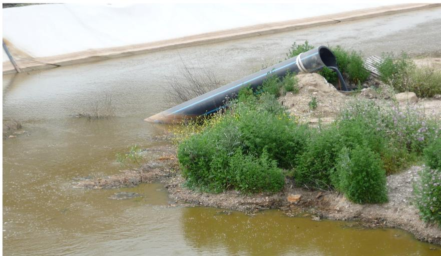
**Figura 13: Le discariche interrato dal sito di Uttaro dimostrano la mancata conformità ai requisiti di sicurezza (percolato ed una ciminiera rotta per l'espulsione di gas) (Fonte: A Sud)**
